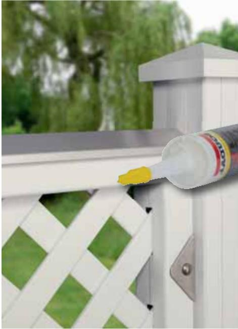
Designaufsatz Alu mit MS-Polymer-Kleber (1398) befestigen.
