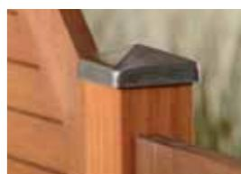
Konstruktiver Holzschutz: Schützen Sie die schichtverleimten Hartholzpfeosten zwingend mit Kapfen aus Edelstahl, Seite 103.
